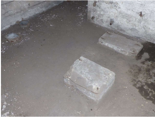
Fot. 04. Maszynownia. W centrum kadru widoczne żelbetowe podstawy silnika Diesla oraz wentylatora ręcznego. W lewej części kadru widoczna rura doprowadzająca napowietrzająca. Stan na luty 2021.
