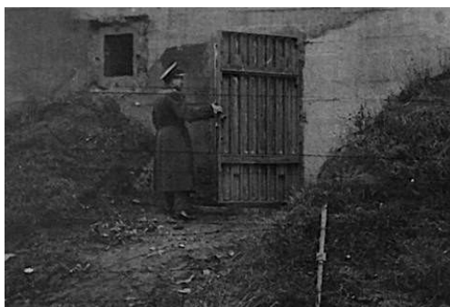
Fot. 03. Fragment fotografii wykonanej przez LWP w ramach inwentaryzacji. Wokół czerpni widoczne cztery kotwy oraz zalepione otwory widoczne jeszcze na Fot. 01. Zwraca uwagę nowe farbomaskowanie, zupełnie odmienne od oryginalnego oraz nowy płot kolczasty ze zdobycznym, niemieckim słupkiem, a także drzwi kratowe ze wstawioną blachą lub płytą. Stan w 1956 r. Fot. LWP/CAW
