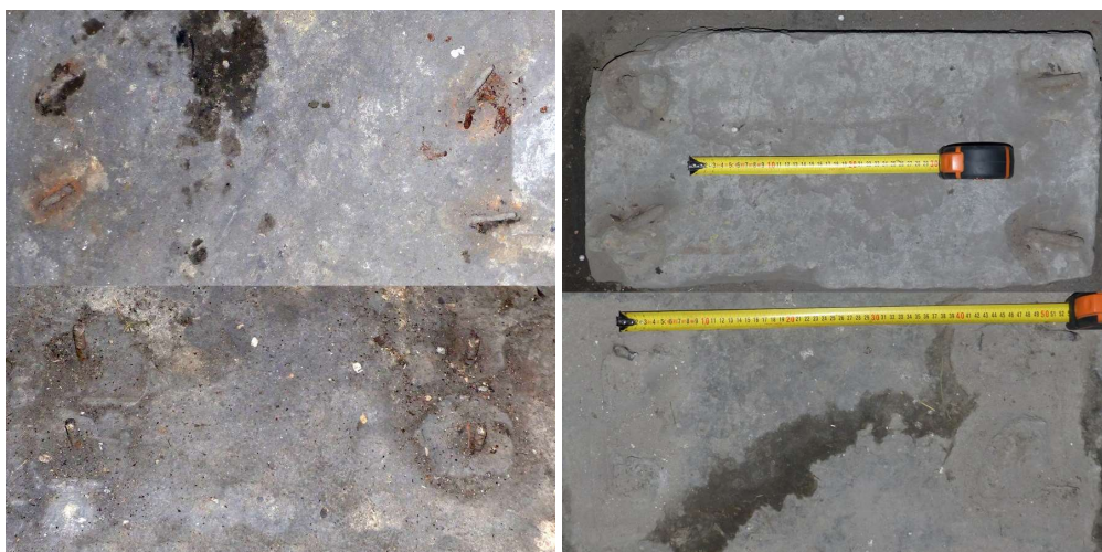
Fot. 06. Porównanie mocowań wentylatorów mechanicznych w schronie Goduła 14 (na górze) oraz Fot. 07. Porównanie mocowań wentylatorów ręcznych w schronie Goduła 14 (na górze) - na betonowej Nowogród 8 (na dole).
