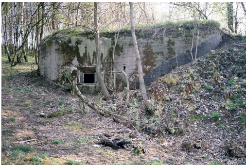
Fot. 02. Ściana boczna schronu ze strzelnicą ścienną ckm. Po prawej od strzelnicy ślad po wyprowadzeniu komina. Fot. Jarosław Ptaszkowski.
