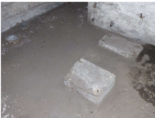
Maszynownia. W centrum kadru widoczne żelbetowe podstawy silnika Diesla oraz wentylatora ręcznego. W lewej części kadru widoczna rura doprowadzająca oraz napowietrzająca. Stan na luty 2021.
