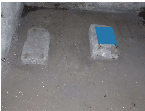
Maszynownia. Od lewej: żelbetowa podstawa wentylatora ręcznego, mocowanie prądnicy, żelbetowa podstawa silnika wysokoprężnego, mocowanie wentylatora mechanicznego. Na podstawę silnika naniesiono niebieskim kolorem sylwetkę spodu silnika Blackstone DB 3. Stan na luty 2021.
