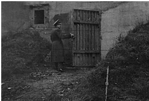
Fragment fotografii wykonanej przez LWP w ramach jednej z inwentaryzacji. Wokół czerpni widoczne cztery kotwy oraz zalepione otwory widoczne jeszcze na Fot. 01. Zwraca uwagę nowe farbomaskowanie, zupełnie odmienne od oryginalnego oraz nowy płót kolczasty ze zdobycznym, niemieckim słupkiem, a także drzwi kratowe ze wstawioną blachą lub płytą. Fot. LWP/CAW
