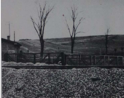
Fot. 03. Niezamontowana zapora składająca się z dwóch wózków. Na nasypie leży jedna z szyn, na jakich miano ustawić wózki. Fot. za. Gegenwartiger Stand...
