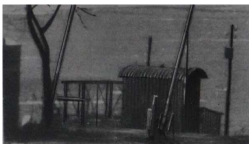
Fot. 05. Fragment fotografii przedstawiającej przejazd kolejowy ze szlabanami oraz zapórę przesuwaną obok schronu nr 10. Zwraca uwagę mały szlaban służący do blokowania wózków w pozycji gotowości. Fot. za. Gegenwartiger Stand...
