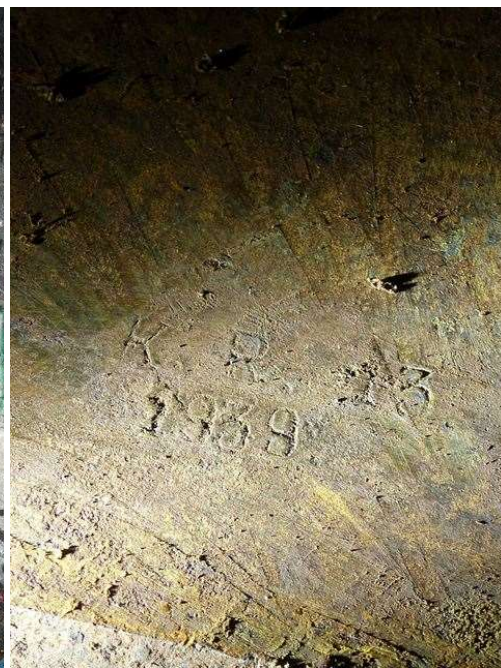
Fot. 08. Sygnatura pancerza sprowadzonego w 1939 r. z Odcinka "Sarny". Oznaczająca Kierownictwo Robót nr 13, które zajmowało się budową fortyfikacji Polesia. Fot. Łukasz Drzensła.
