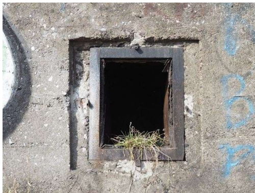
Fot. 13. Czerpnia w ścianie tylnej schronu.
