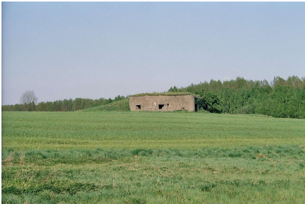
Fot. 01. Schron Godula 16a od strony bocznej. Widoczny rozległy nasyp czołowy. Stan pod koniec lat 90. Fot. Jarosław Ptaszkowski.
