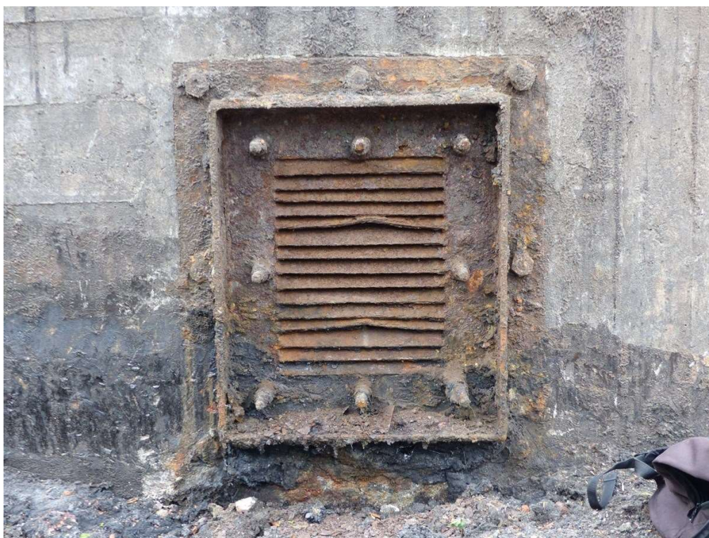
Fot. 15. Pancierz czerpni powietrza w schronie nr 13.
