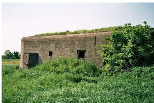
Fot. 04. Schron od zapola, w lewej części kadru widoczne drzwi pancerne do garażu armaty ppanc. Stan pod koniec lat 90. Fot. Jarosław Ptaszkowski.
