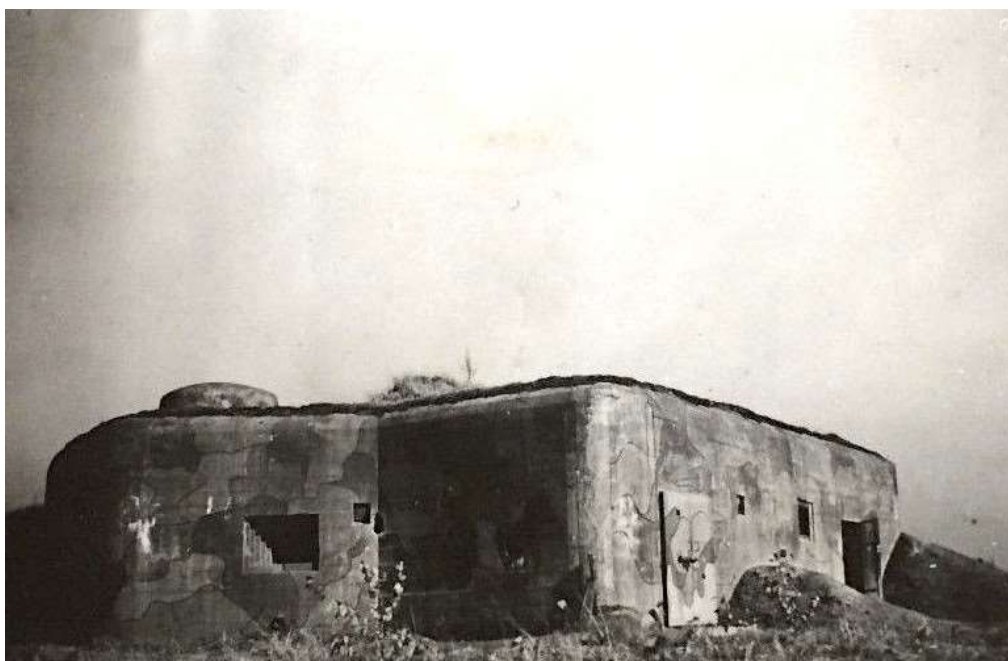
Fot. 02. Schron od strony zapola. Na stropie widoczna kopuła pozorna. Elewacja obiektu pokryta jest malowaniem maskującym. Fot. dokumentalna.
