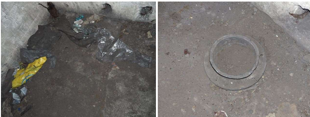
Fot. 11. Kanał podłogowy w izbie załogi. Przy ścianie widoczne stalowy profil.
