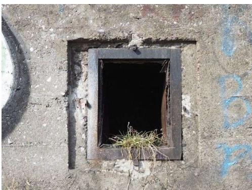
Fot. 13. Czerpnia w ścianie tylnej schronu.
