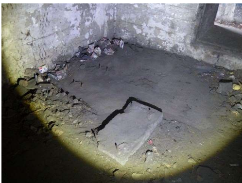
Fot. 09. Maszynownia schronu nr 16a. W centrum kadru podstawa awaryjnego wentylatora o napędzie ręcznym. Zwracają uwagę szpilki w narożnikach. Nieco wyżej ślad po podstawie silnika. Po lewej cztery szpilki, do których mocowano wentylator główny o napędzie mechanicznym. Stan w 2020 r. Fot. Łukasz Drzensła.
