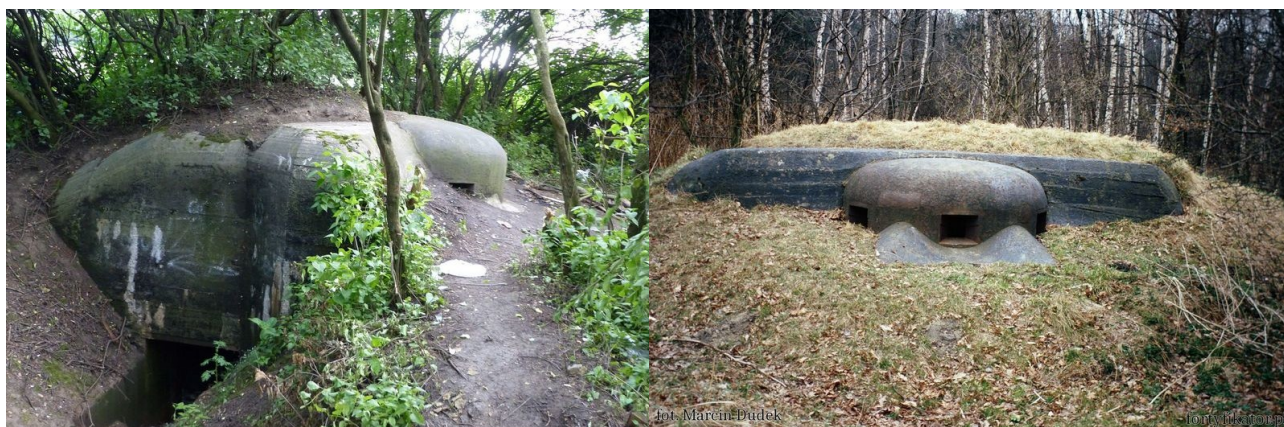
Fot. 03. Schron nr 3, p.o. „304,7”. Kopuła pancerna stanowiła prawie 30% kosztu budowy schronu. Fot. Łukasz Drzensła. Fot. 04. Schron nr IV, p.o. „Szyb Artura”. Stan w 1997 r. Fot. Marcin Dudek.
