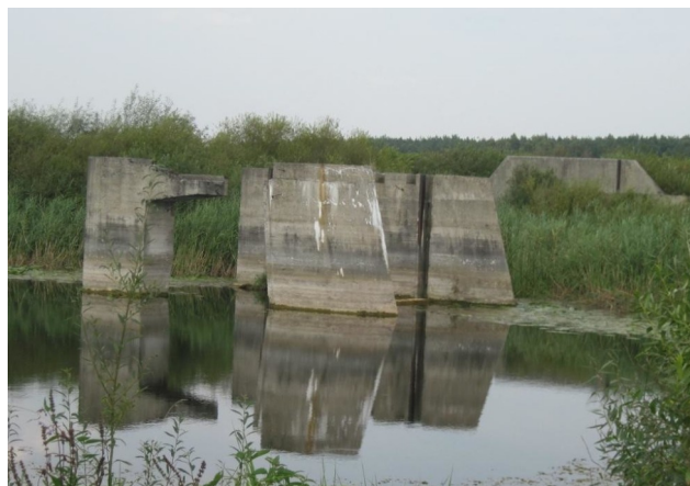
Fot. 05. Jaz zlokalizowany ok 15 km na północ od Łucka. Fot. ing, za: https://reibert.info/threads/oboronni-gidrotexnichni-sporudi.134305/ .
