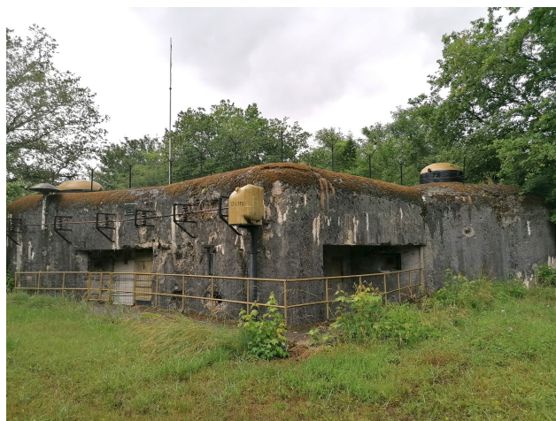
Fot. 09. Francuski schron Casemate de Wittring. W przypadku obiektu francuskiego również dostrzec możemy znaczne podobieństwo. Najistotniejszymi zbieżnymi rozwiązaniami, jest charakterystyczne przedłużenie ściany tylnej, oraz rów diamentowy, występujący przed wejściem.
