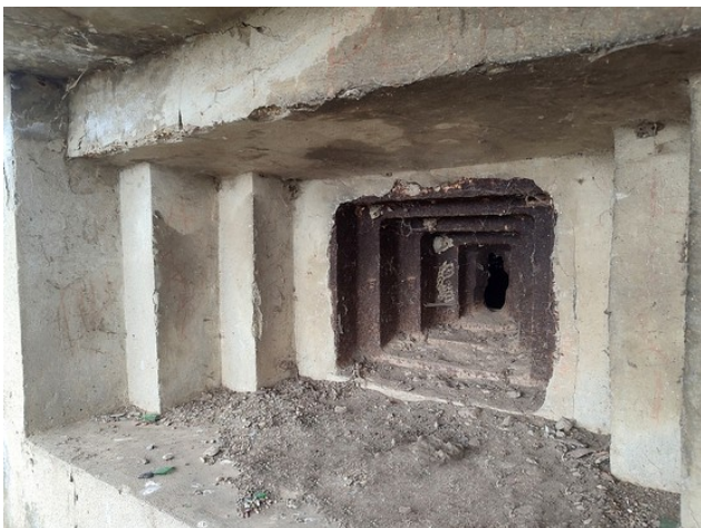
Fot. 32. Pancierz (o czechosłowackim rodowodzie) zwraca głębokie osadzenie pancierza w ścianie oraz stosunkowo duże stopniowanie, przeciw rykoszetowe.
