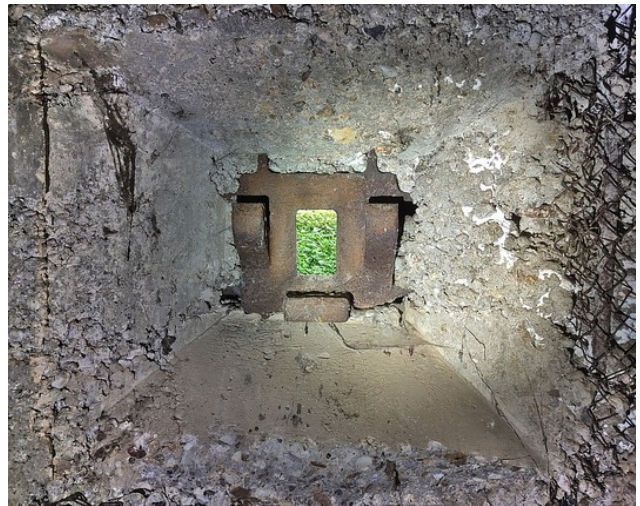
Fot. 23. Pancierz strzelnicy pomocniczej, widziany od wewnątrz. Również w tym przypadku, zamknięcie miałyby charakter oddzielnego segmentu. W przypadku tego pancierza nie udało się znaleźć, żadnych sygnatur.
