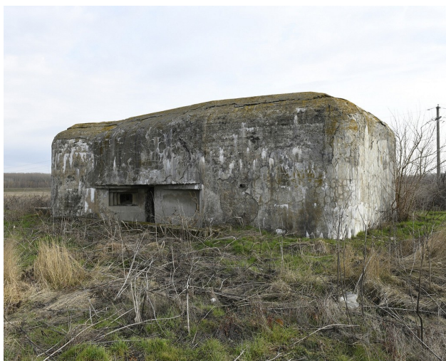
Fot. 07. Schron nr 3. Jako jedyny został wybudowany jako jednostronny. Nietypowe było w rozplanowaniu obiektu umieszczenie dodatkowej strzelnicy do obrony zapola w oddzielnej izbie.
