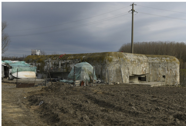
Fot. 03. Schron nr 2. Obiekt jest dużo większy od obiektów sąsiednich, co widać po znacznie szerszej strefie wejściowej.
