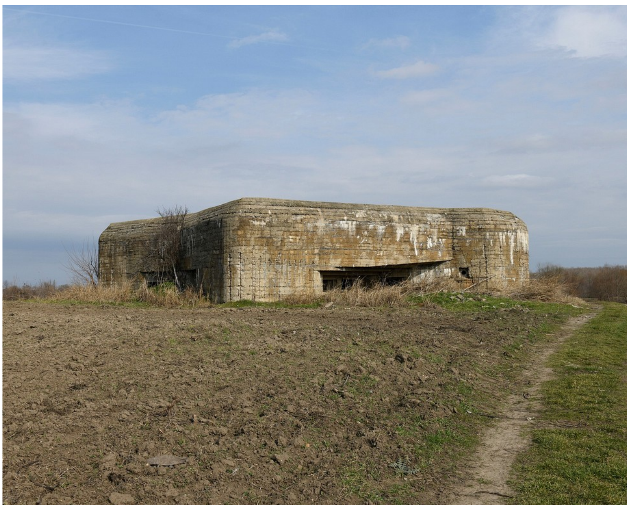
Fot. 01. Schron nr 1 - widok ogólny.
