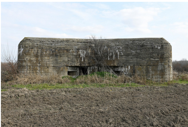
Fot. 02. Schron nr 1 widok na zapole, nadsypana przed wejściem ziemia zakrywa niewidoczny rów diamentowy.
