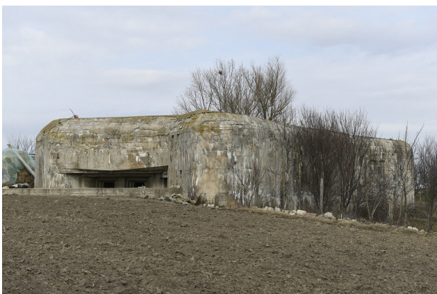
Fot. 04. Schron 2 widok z przedpola, rozległa ściana czołowa winna być osłonięta nasypem ziemnym. W tym przypadku jednak nasyp został zniesiony, bądź co bardziej prawdopodobne, nigdy nie usypany.
