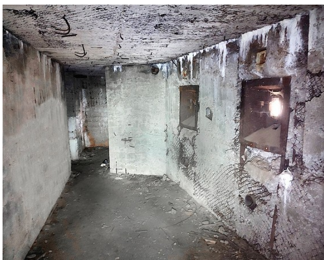
Fot. 10. Wnętrze prawej izby bojowej schronu nr 1. Warto zwrócić uwagę na częściowo zachowaną siatkę przeciwodpryskową, rury, którymi do rowu diamentowego miano wyprowadzać łuski, oraz elementy szalunku w miejscu przyszłego mocowania lawety.
