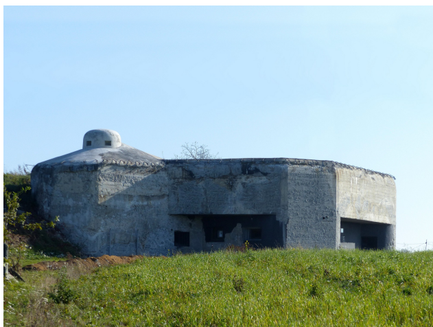
Fot. 08. Czechosłowacki Pěchotní srub MO-S 21 U jaroše. Obiekt zestawiony dla porównania z rumuńskim odpowiednikiem. Największą różnicą wizualną jest istnienie dzwonów pancernych (w tym przypadku replik). Stan w 2019 r. Fot. Łukasz Drzensla.
