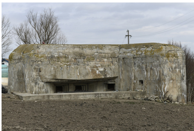
Fot. 05. Schron nr 2, widok na strzelnicę. Wyraźnie widoczna jest krawędź rowu diamentowego - w innych obiektach zastonięta.
