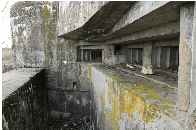
Fot. 19. Schron nr. 3. Efektowne zdjęcie na strzelnicę. Wyraźnie widoczne jest charakterystyczne ukształtowanie nawisu/okapu ochronnego, oraz głębokie osadzenie strzelnic. Na załamaniu ścian widoczny jest zdekompletowany wylot gazów prochowych. Widać również częściową głębokość rowu diamentowego, oraz zrzutnię łusek.
