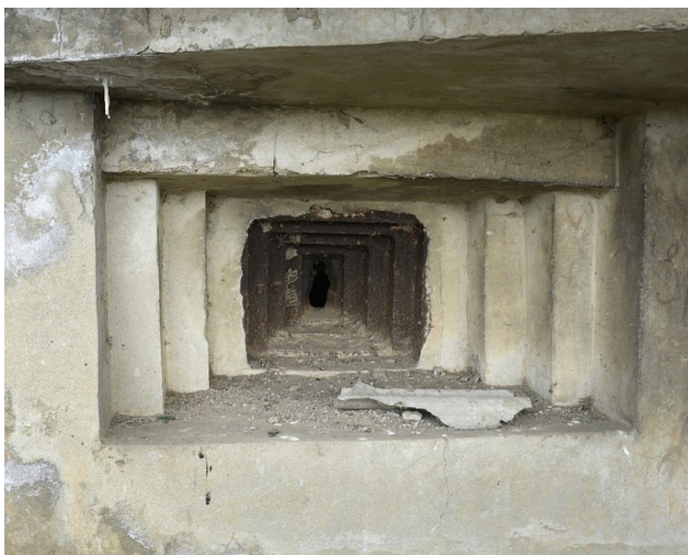
Fot. 24. Strzelnica do obrony zapola w schronie nr 3. Pancierz został w oryginale opracowany dla czechosłowackiego schronu LO vz. 37, w tym przypadku jednak z powodzenie wykorzystany, w fortyfikacji ciężkiej.
