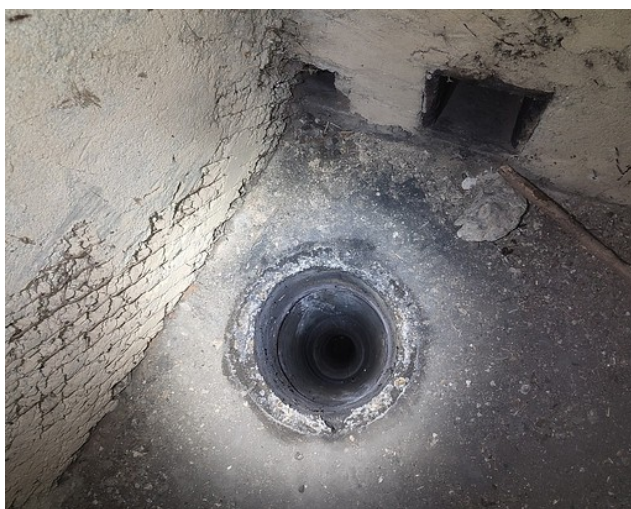
Fot. 30. Studnia wyłożona z betonowych kręgów w schronie nr 3. Otwory w ścianie były (zdekompletowany) wylot zabrudzonego powietrza, prawdopodobnie wyjściami kablowymi. Widoczne otynkowanie wewnętrzne ścian. Fot. 31. Najlepiej zachowany (zdekompletowany) wylot zabrudzonego powietrza, prawdopodobnie wyjściami kablowymi. Widoczne otynkowanie wewnętrzne ścian.
