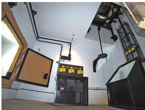
Fot. 20. Wystawa ilustrująca planowane rozwiązanie działania reflektora. Reflektor znajduje się w pomieszczeniu, do którego prowadzi otwór po lewej stronie zdjęcia. W prawym górnym rogu lustro wysuwno-obrotowe. Poniżej
