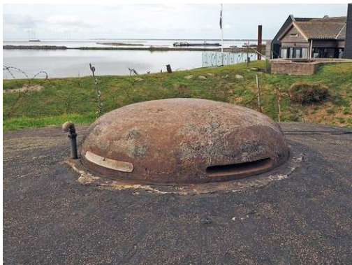
Fot. 17. Kopuła obserwacyjna na stopie schronu nr IV. Fot. Łukasz Drzensła.
