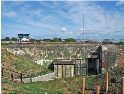
Fot. 05. Schron VII od strony zapola. Pośrodku kadru dwa ustępy, po prawej stronie wejście do schronu. Powyżej kopuła obserwacyjna. Po lewej stronie pancerna klapa zamykająca otwór dla lustra systemu reflektorowego (szerzej w dalszej części tekstu). W tle zatoka IJsselmeer oraz typowe dla Holandii wiatraki. Fot. Łukasz Drzensła.
