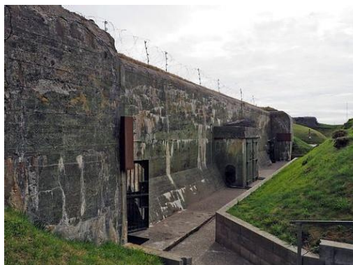
Fot. 03. Schron IV od zapola. Po lewej stronie widoczne drzwi kratowe, którymi zamykano wejścia do schronów. W centrum kadru widoczny pisuar i dwa ustępy. W głębi kadru drugie wejście do schronu wraz z uchem. W tle schron Regelbau 667 wzniesiony przez Niemców w 1943 r. w ramach Wału Atlantyckiego. Na stropie schronu drut kolczasty oparty na słupkach fortyfikacyjnych. Fot. Łukasz Drzensła.
