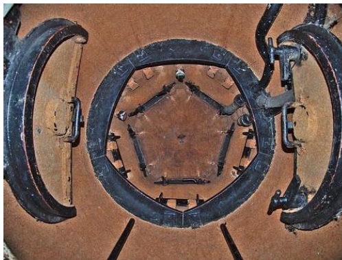
Fot. 18. Wnętrze kopuły obserwacyjnej. Fotografie wykonano z dołu do góry. Kolejno widoczne z dołu do góry są: zamknięcia wjazdu do kopuły, "stoliki", zamknięcia szczelin obserwacyjnych w uchwytach (3 z 5 szt) oraz otwory obserwacyjne tworzące pięciokąt (wszakże kopuła miała tych otworów 5). Fot. Łukasz Drzensła.
