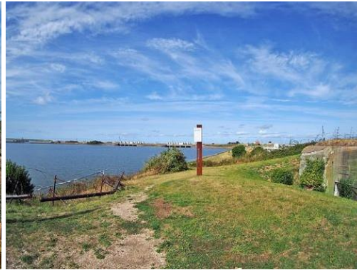
Fot. 06. Zapole schronu VI. W tle Tama Zamykająca wraz ze śluzami. Po lewej stronie rekonstrukcja zapór przeciwpiechotnych ustawionych w roli zapory turysto-odpornej, ponieważ w tym miejscu znajduje się zagłębienie ze schronem maszynowni "A". Fot. Łukasz Drzensła.
