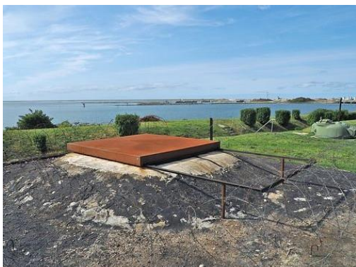
Fot. 19. Pancerna klapa zamykająca otwór na lustro systemu reflektorowego. Fot. Łukasz Drzensła.
