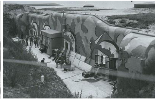
Fot. 08. Jeden ze schronów z Den Oever, wyjątkowo dobrze ilustrujący kamuflaż, który był stosowany także w Kornwerderzand. Wręcz osobliwe plamy miały sprawiać złudzenie elementów budowli, które w rzeczywistości nie istniały, a istniejące rozmywać. Fot. dokumentalna. za. geschiedenislokaalregionaalarchiefalkmaar.nl/ .
