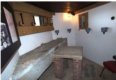
Fot. 14. Strzelnica ścienna ckm w schronie nr V wraz z półką-podstawą dla podstawy polowej ckm. Fot. Łukasz Drzensła.
