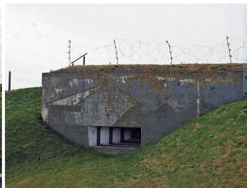
Fot. 04. Strzelnica ckm schronu IV. Rzucają się w oczy jej spore rozmiary, a także znajdujący się nad nią fragment oryginalnego malowania maskującego. Na kolor zielony z żółtymi wzorami schrony przemalowały wojska NATO po wojnie. Fot. Łukasz Drzensła.
