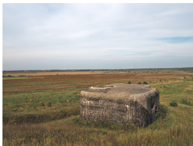
Fot. 02. Schron Lubasza 17b górujący nad planowanym zalewem mobilizacyjnym „Zbuż”.
