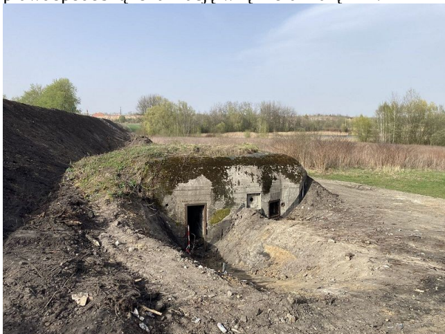
Fot. 16. Ściana tylna schronu Łagiewniki 2.
