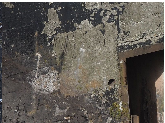
Fot. 08. Zdekompletowana czerpnia powietrza w schronie Łagiewniki 3. Poniżej czerpni widoczna rura wyrzutu gazów prochowych z ckm. Jej umiejscowienie należy ocenić jako niefortunne. Fot. 09. Druga, zaplombowana czerpnia w schronie Łagiewniki 3. W narożniku widoczna rura niewielkiej wyrzutu gazów prochowych z ckm. Jej umiejscowienie należy ocenić jako niefortunne.
