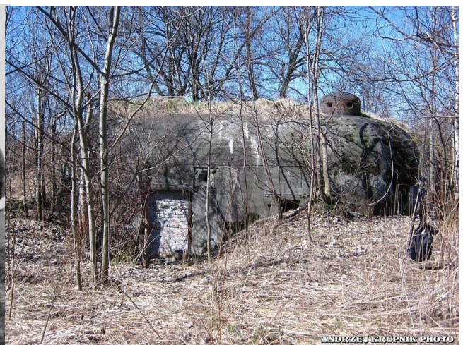
Fot. 06. Schron Łagiewniki 6 od zapola. W centrum kadru widoczna "tajemnicza wnęka". Po lewej kadru widoczne zamurowane przejście, powyżej po zdekompletowana czerpnia powietrza w silnym skrócie. Po prawej widoczna czerpnia powietrza. Zwracają uwagę w perspektywie. Po prawej od wnęki drzwi kratowe, miarę dobrze zachowane nasypy. Stan w 2017 r. Fot. Andrzej Krupnik za. The Bunker Raiders Fot. 07. Schron Łagiewniki 6 od zapola. W centrum kadru widoczna "tajemnicza wnęka". Po lewej kadru widoczne zamurowane przejście, powyżej po zdekompletowana czerpnia powietrza w silnym skrócie. Po prawej widoczna czerpnia powietrza. Zwracają uwagę w perspektywie. Po prawej od wnęki drzwi kratowe, miarę dobrze zachowane nasypy. Stan w 2017 r. Fot. Andrzej Krupnik za. The Bunker Raiders Fot. 08. Zdekompletowana czerpnia powietrza w schronie Łagiewniki 3. Poniżej czerpni widoczna rura wyrzutu gazów prochowych z ckm. Jej umiejscowienie należy ocenić jako niefortunne. Fot. 09. Druga, zaplombowana czerpnia w schronie Łagiewniki 3. W narożniku widoczna rura niewielkiej wyrzutu gazów prochowych z ckm. Jej umiejscowienie należy ocenić jako niefortunne.
