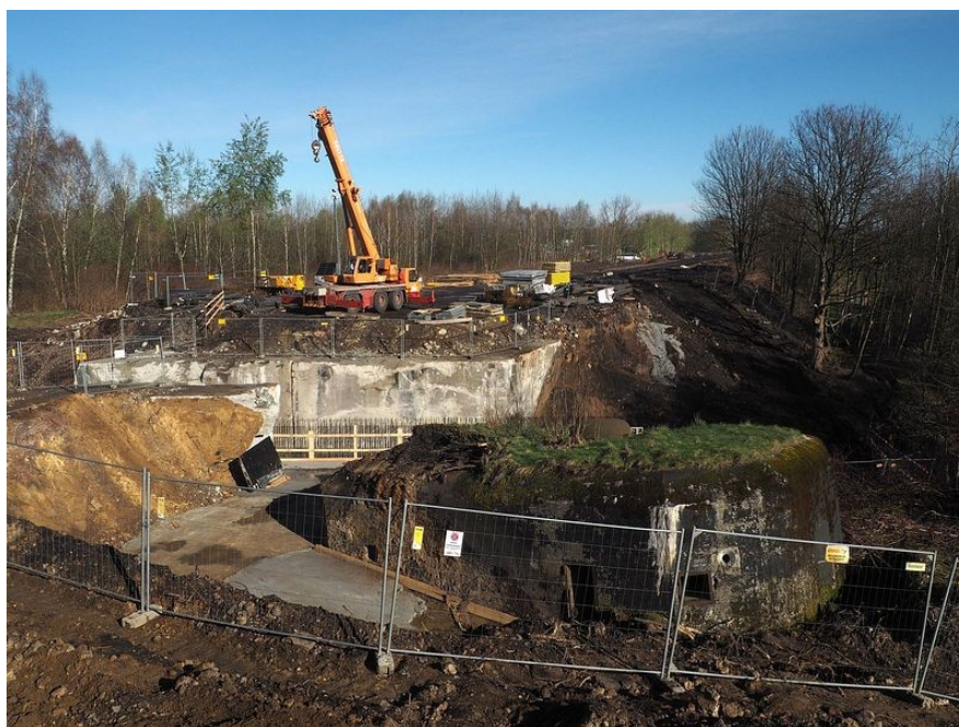
Fot. 01. Schron Łągiewniki 3 od zapola obecnie. Po lewej stronie w rejonie świeżo wylanego betonu widoczna "tajemnicza wnęka".
