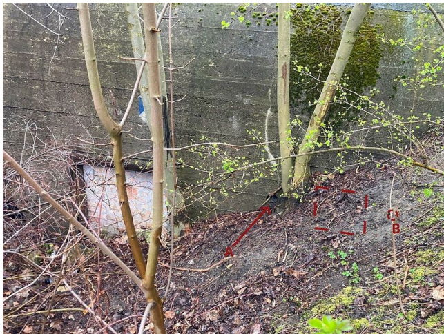
Fot. 14. Ściana tylna schronu Łagiewniki 11. Strzałka wskazuje rurę "A". Przerywaną linią zaznaczono prawdopodobną lokalizację wnęki oraz rurę "B". Fot. 15. Izba bojowa armaty ppanc w schronie Łagiewniki 11. Strzałki wskazują na rury "A" oraz "B".
