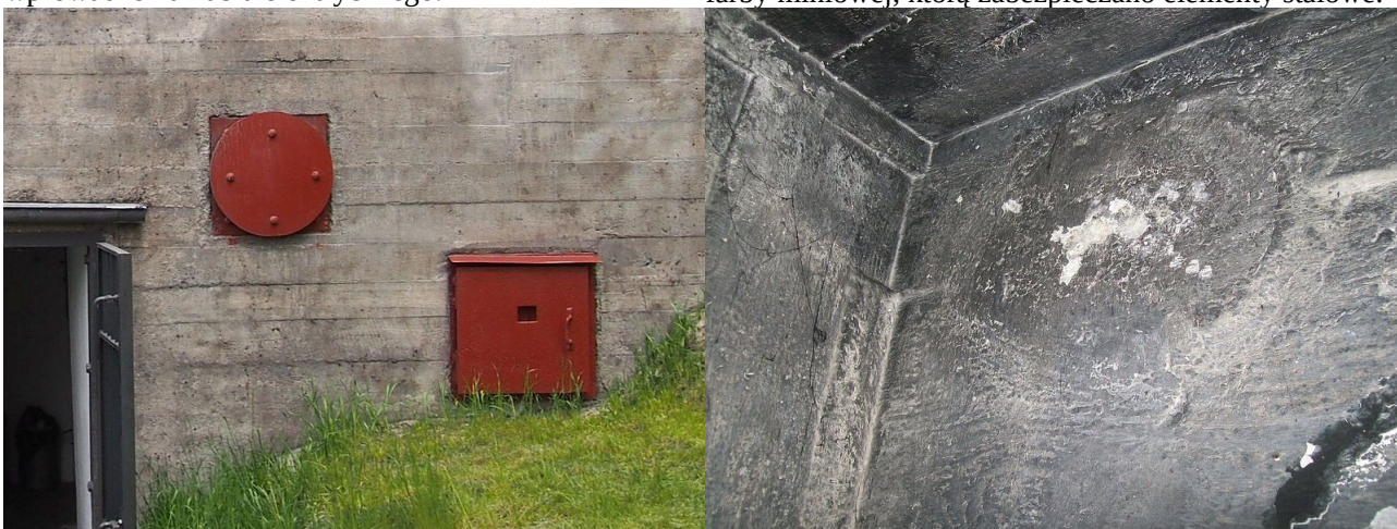
Fot. 12. Ściana tylna schronu Łagiewniki 5. Okrągły element w centrum kadru to czerpnia powietrza zschronie Łagiewniki 6. Fot. 13. Zacementowany wylot "ślepej" czerpni w kompletnym pancierzem.
