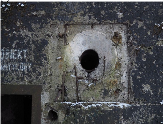
Fot. 08. Zdekompletowana czerpnia powietrza w schronie Łagiewniki 3. Poniżej czerpni widoczna rura wyrzutu gazów prochowych z ckm. Jej umiejscowienie należy ocenić jako niefortunne. Fot. 09. Druga, zaplombowana czerpnia w schronie Łagiewniki 3. W narożniku widoczna rura niewielkiej wyrzutu gazów prochowych z ckm. Jej umiejscowienie należy ocenić jako niefortunne.
