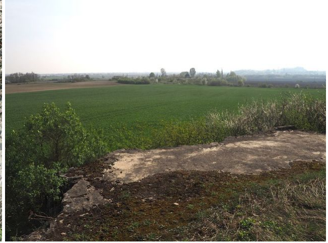
Fot. 05. Widok ze stropu schronu 205 w kierunku czołowym.
