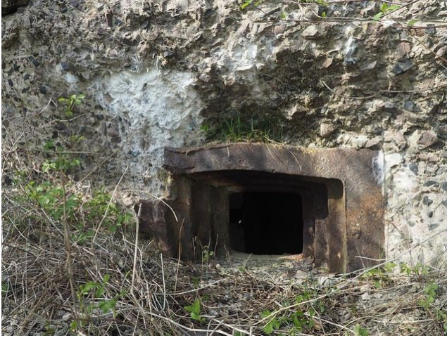
Fot. 04. Uszkodzony ostrzałem oraz wybuchem pancierz DOT-4 schronu 205.
