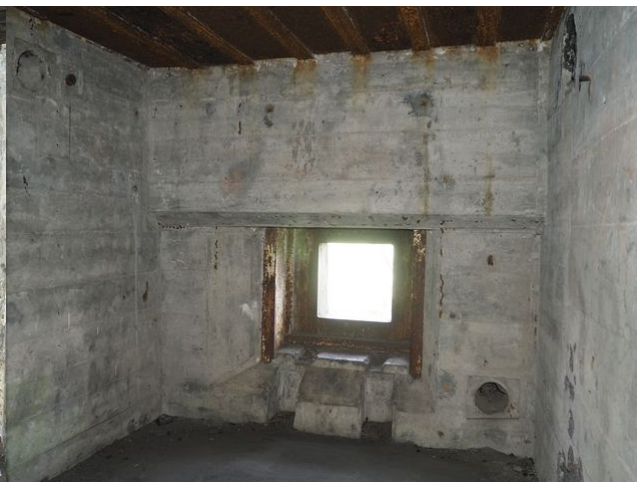
Fot. 11. Strzelnica ckm w schronie Mokwin 22 do rozległe rozkucia półek strzelnic wyprofilowane celem prowadzenia ognia w pozycji "siedząc". Widoczne utorowania miejsca dla elementów ruchomych podstawy ckm. Rzuca się w oczy brak rozkuców świadczący o tym, że forma strzelnicy była pierwotnie zaplanowana w ten sposób.
