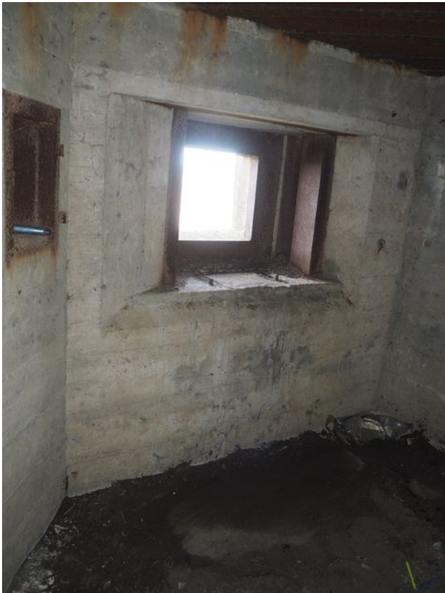
Fot. 06. Strzelnica ckm w schronie Mokwin 20. Widoczne obniżenie półki strzelnicy tuż za śrubami mocującymi podstawę ckm. U góry brak haków. Na podłodze brak ceowników.
