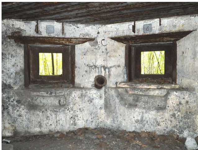
Fot. 10. Strzelnice schronu Kochłowice 74. Widoczne rozległe rozkucia półek strzelnic wyprofilowane celem prowadzenia ognia w pozycji "siedząc". Widoczne utorowania miejsca dla elementów ruchomych podstawy ckm. Fot. Łukasz Drzensła.
