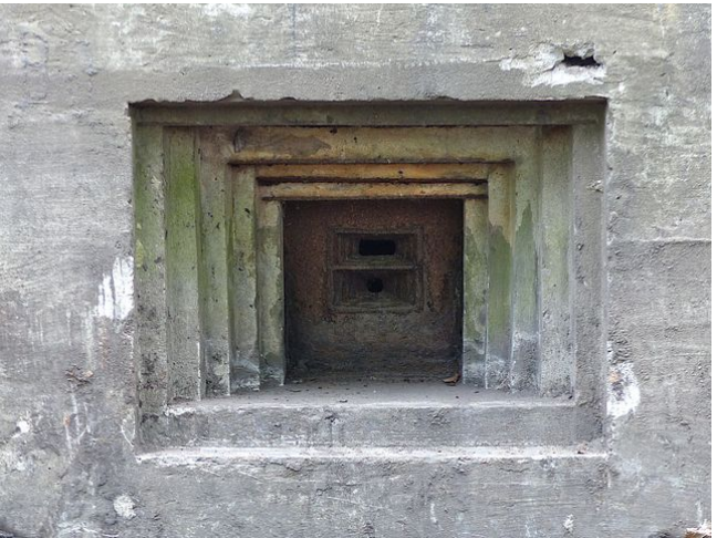
Fot. 02. Strzelnica ckm typu 36 w schronie Bobrowniki 48. Fot. 03. Strzelnica ckm typu 37 w schronie Godula 13. Pancierz jest tylko nieznacznie cofnięty względem zewnętrznej krawędzi ściany. Fot. Łukasz Drzensła. Zwraca uwagę sporych rozmiarów rozglifienie z drobnymi schodkami. Fot. Łukasz Drzensła.
