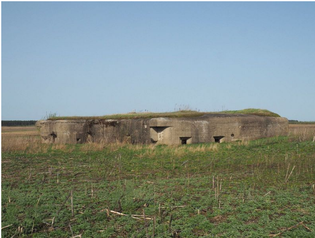
Fot. 01. Schron Antonówka 4 "Junak" (1938). W centrum kadru widoczne dwie strzelnice ckm typu 37.
