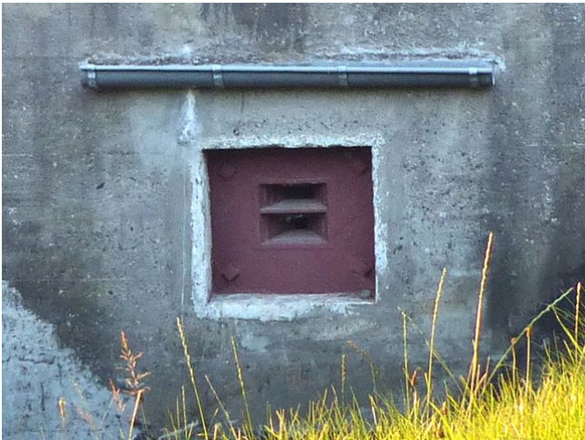
Fot. 02. Strzelnica ckm typu 36 w schronie Bobrowniki 48. Fot. 03. Strzelnica ckm typu 37 w schronie Godula 13. Pancierz jest tylko nieznacznie cofnięty względem zewnętrznej krawędzi ściany. Fot. Łukasz Drzensła. Zwraca uwagę sporych rozmiarów rozglifienie z drobnymi schodkami. Fot. Łukasz Drzensła.
