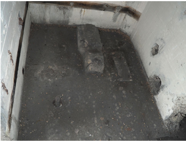
Fot. 04. Podłoga maszynowni schronu. Największy betonowy postument to łączona podstawa silnika i prądnicy. Obok niej czerpniowego. Obok półkolistą wnęką dla pieca. Po prawej stronie mniejszy cokół służący dla wentylatora mechanicznego. Fot. od niej strzelnica broni ręcznej obrony wejście. Fot. Łukasz Drzensła.
