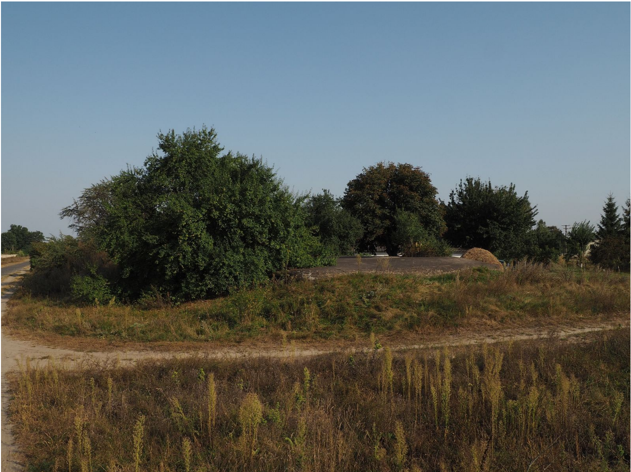
Fot. 01. Strop schronu Lubasza 10 "Zator" widziany z drogi.
