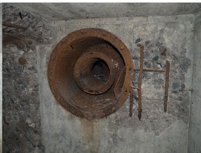
Fot. 03. Czerpnia powietrza w schronie Lubasza 10 "Zator". Widoczny załamany przewód.
