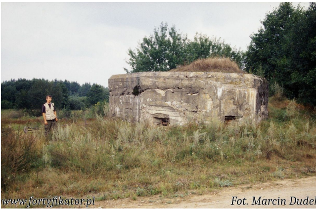
Fot. 02. Schron zmodernizowany w pierwszej połowie lat 30. Widoczne inne szalowanie w rejonie czołowej strzelnicy.
