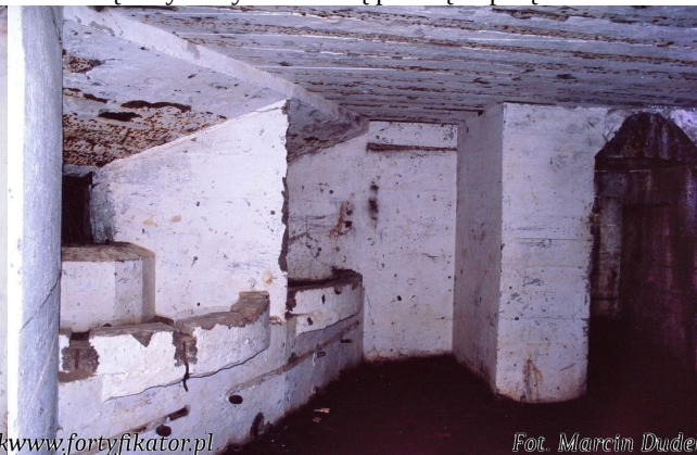
Fot. 18. Wnętrze schronu z 1937 r. Po lewej strzelnica broni ręcznej, a po prawej strzelnica ckm. Fot. 19. Wnętrze schronu z okresu 1935-1936. Po lewej dwie strzelnice ckm, w głębi wejście do kopuły.
