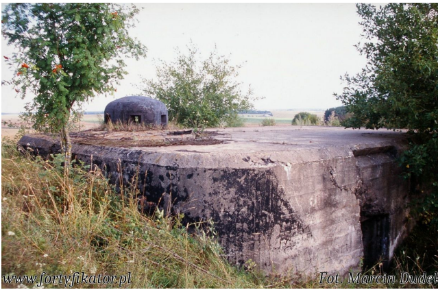
Fot. 10, 11. Pododcinek "Horodyszcz", schron dowodzenia w rejonie Zaosia. Nad wejściem widoczne jest zagłębienie na oparte skośnie belki tworzące drewniano-ziemną przelotnię. Widoczna kopuła i otwór peryskopu. W tle, ponad stopem w dalszej perspektywie widoczne zabudowanie folwarku Mickiewiczów w Zaosiu.
