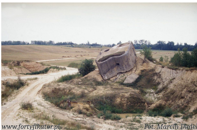
Fot. 16. Osuwający się schron Darewo 16 to typowy obiekt z okresu 1937-1938. Widoczna sytuacja w położeniu pancernym. Zamontowano (a później odcięto...) jedynie schronu powstała w wyniku działania żwirowni. Fot. 17. Schron Darewo 22 miał posiadać trzy kopuły środkową - wykorzystano starą pruską kopułę.
