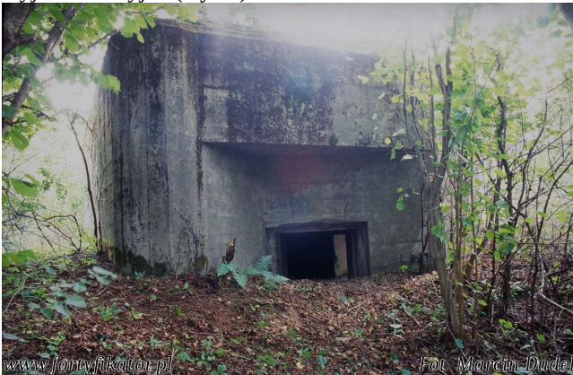
Fot. 14. Ściana boczna ze strzelnicą schronu obrony przeciwpancernej Minicze 2 (1938). Po lewej stronie ucholewej wjazd dla armaty, przeznaczony do zamknięcia (orylion) osłaniający strzelnicę od przedpola.
