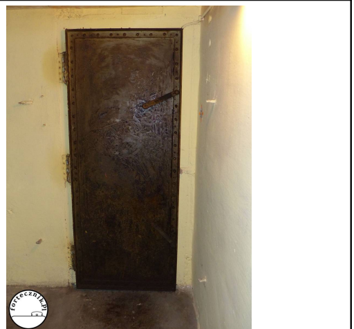
Fot. 28. Pancerne drzwi gazoszczelne. Dobrze widać smar nałożony przez Ludowe Wojsko Polskie.
