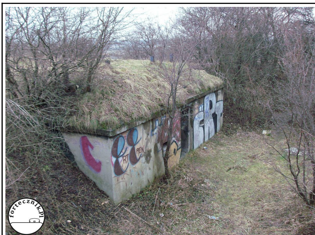
Fot. 29. Magazyn amunicji. 2008 rok.
