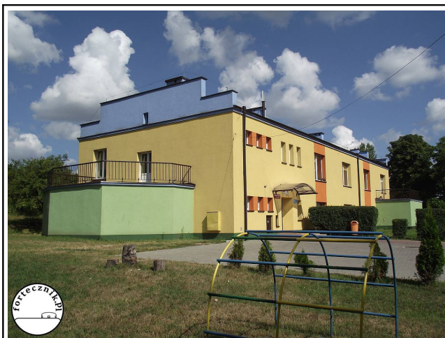
Fot. 08. Budynek mieszkalny koszar. Na pierwszym planie południowy schron bojowy. Strzelnice przykryła nowa elewacja. Usunięto również mur z krenelażem z tarasu na stropie, z którego można było również prowadzić ogień broni ręcznej. 2013 rok.
