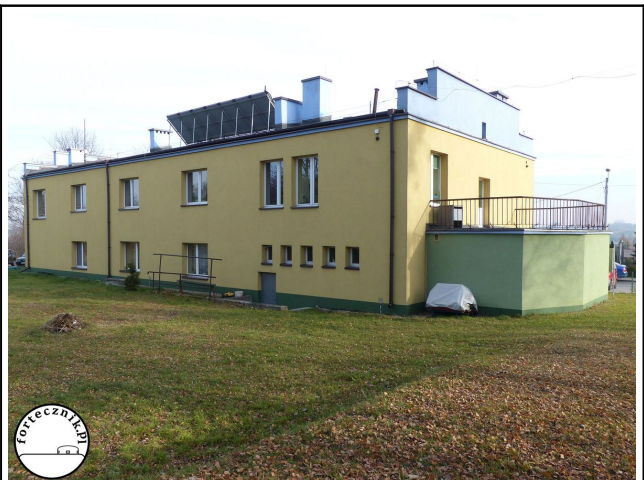
Fot. 04. Ten sam budynek od strony zachodnio-południowej. 2019 rok.
