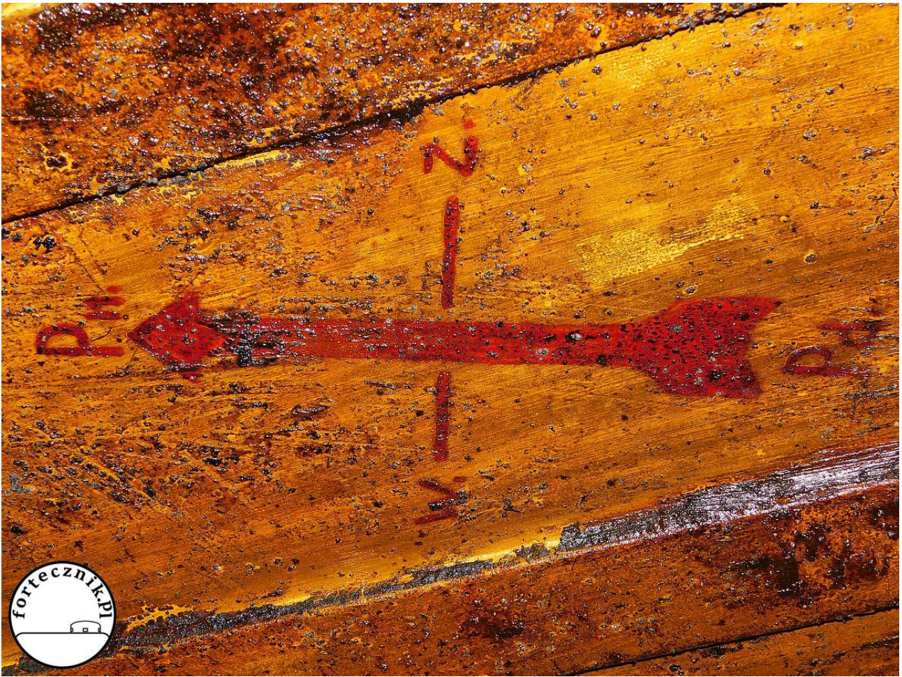
Fot. 26 "Róża wiatrów" na stropie zachodniej izby bojowej w schronie północnym.
