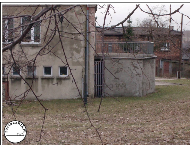
Fot. 09. Zdjęcie południowego schronu, widok od strony zachodniej. Widoczne drzwi kratowe. 2008 rok.
