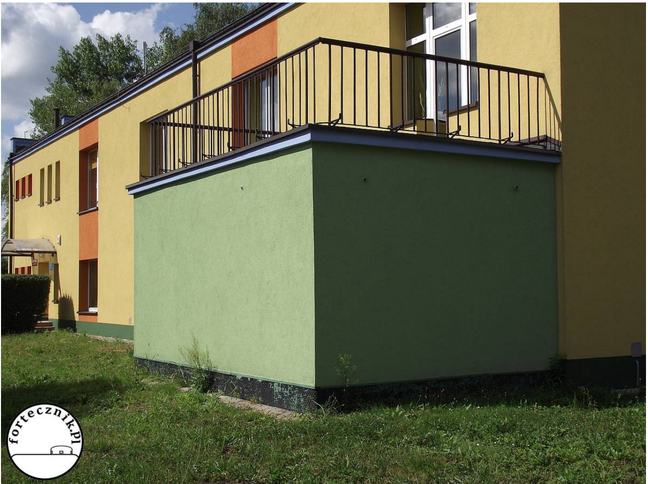
Fot. 21 Schron północny. 2013 rok.
