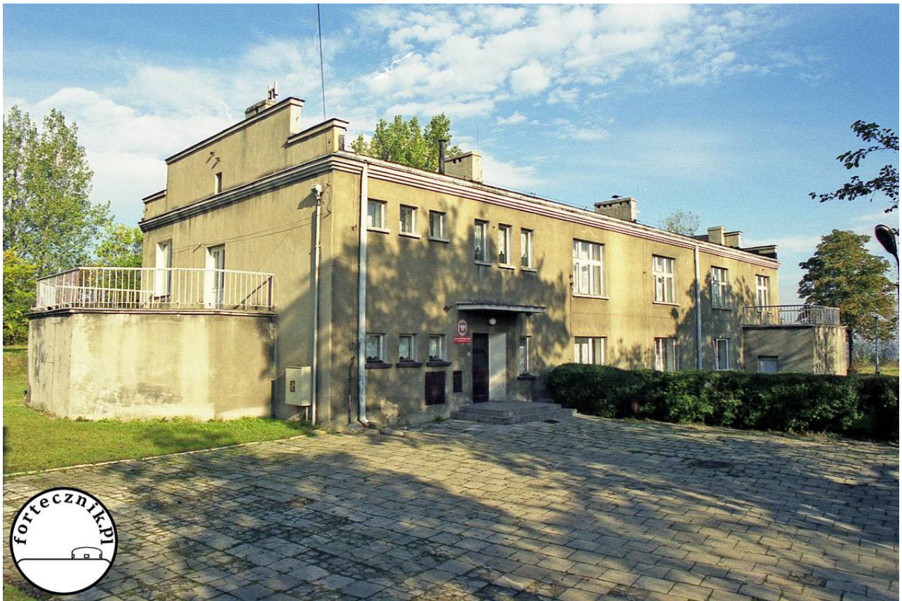
Fot. 02. Budynek mieszkalny od strony wschodniej. Fot. zbiory prywatne. 1999 rok.
