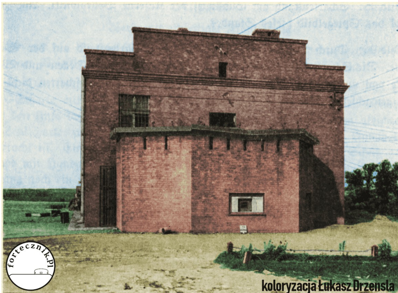
Fot. 01. Zdjęcie archiwalne przedstawiające południowy schron bojowy. Fot.za. Denkschrift über die polnische Landesbefestigung , (s. 99). Koloryzowane.
