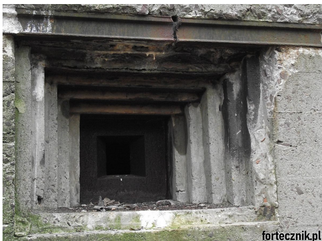
Fot. 03 Strzelnica ckm w schronie nr 15 (p.o. "Godula"). Wkładka przeciwykoszetowa zdemontowana.
