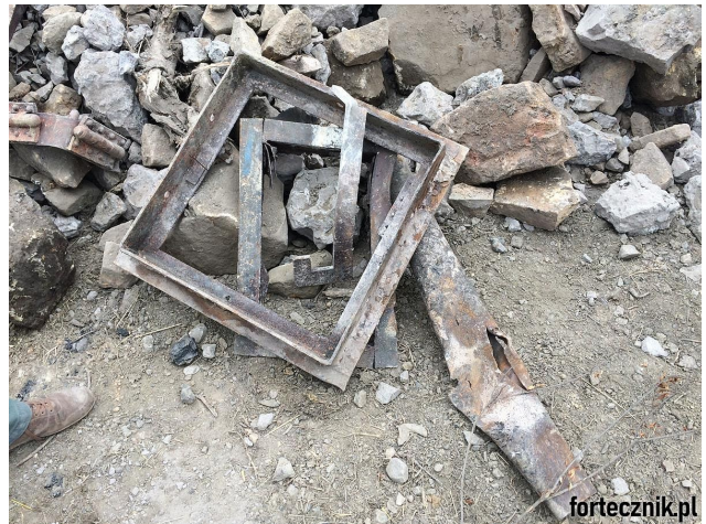
Fot. 11. Elementy stalowe pochodzące z wyburzonego schronu nr 82 (p.o. "Kochłowice"). Wspomniany wcześniej hak, ościeznica wewnętrznego gazoszczelnego zamknięcia wyłazu, rama czepni powietrza oraz rura wentylacyjna.
