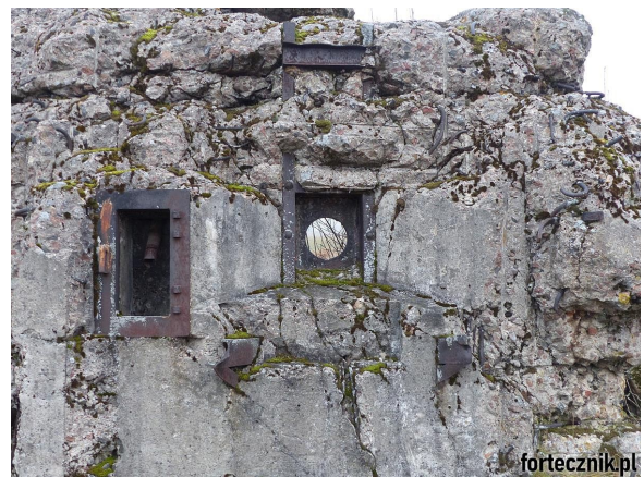
Fot. 13. Stanowisko bojowe ckm chronione pancerzem gazoszczelnym z 1939 roku w ruinach schronu Odcinka "Wizna" pod Kurpikami. Widoczne elementy konstrukcji montażowej.
