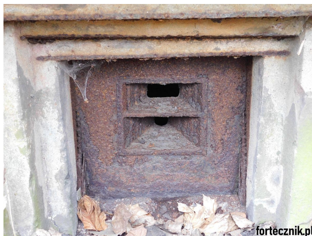
Fot. 04. Pancierz w strzelnicy ckm w schronie nr 13 (p.o. "Godula"). Zachowana wkładka przeciwykoszetowa.
