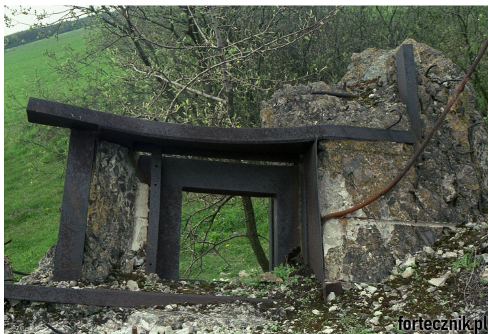
Fot. 08. Konstrukcja montażowa pancerza w ruinach jednego ze schronów odcinka "Sarny". Fot. J. Sadowski.
